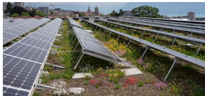
PRINCIPE D'AMÉNAGEMENT ET EXEMPLE D'UNE TOITURE BIOSOLAIRE (SOURCE SPADOM ET BENOIT RENEVEY)
