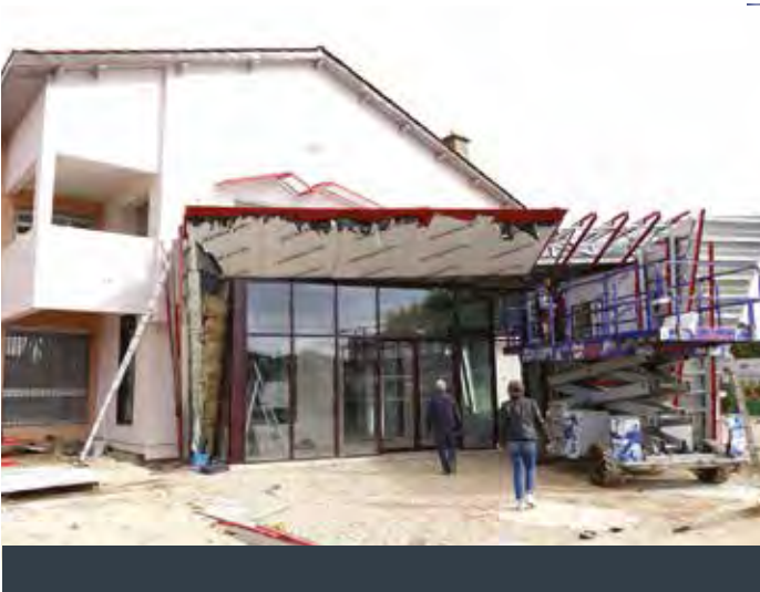
Entrée du Pôle en construction
